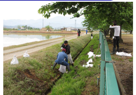
▲普段、掃除が行き届かないグラウンド周りの側溝の泥上げをしていただきました。
